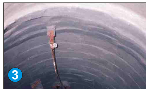
3. Il risultato - Sigillatura e protezione a prova d'acqua. ENECRETE WS ha sigillato e protetto in pochi passaggi.
