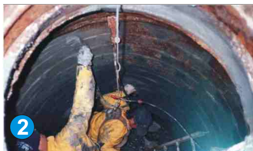
2. Dopo aver otturato le perdite con ENECRETE WP, le pareti sono pennellate con due mani di WS...
